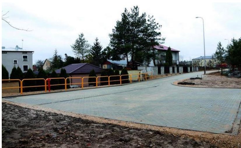
Rozbudowa ulic na osiedlu Staszówek
