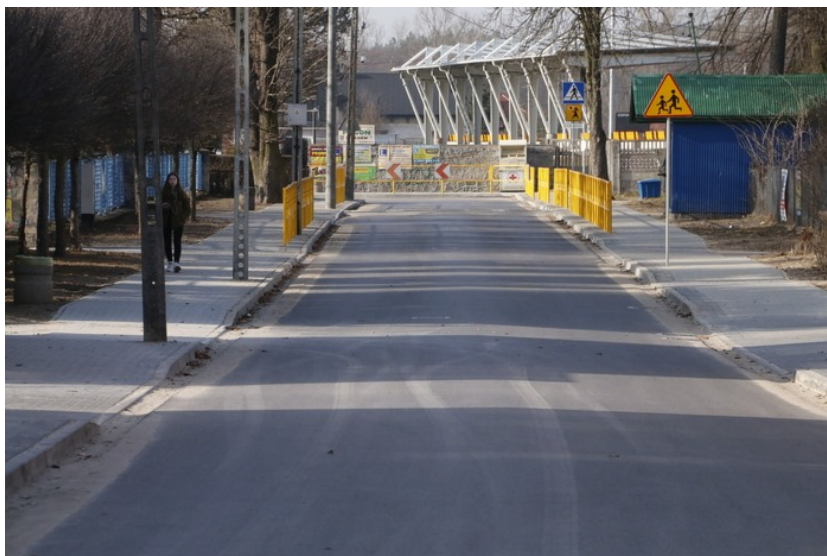
Przebudowa ul. Koszarowej w Staszowie
