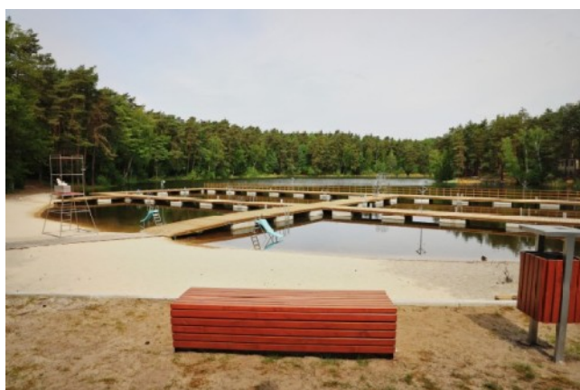
Fot 15. Golejów po pierwszym etapie rewitalizacji
