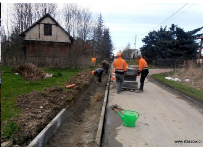
Fot 22. Prace przy utwardzaniu pobocza w Koniemłotach
