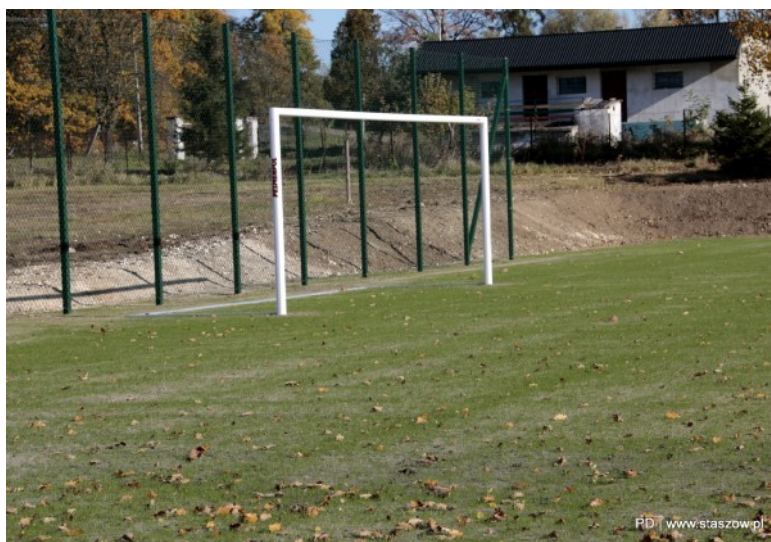
Fot 65. Przebudowa boiska w Wiązownicy - Kolonii
