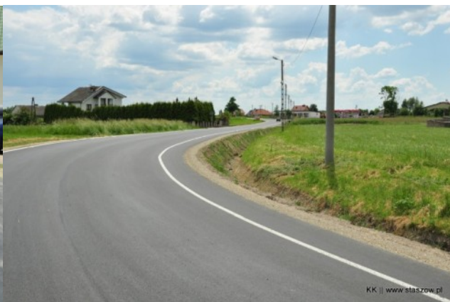
Fot 24. Przebudowa drogi w Koniemłotach
