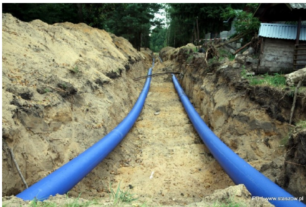
Fot. 14. Wymiana sieci wodociągowej w Staszowie
