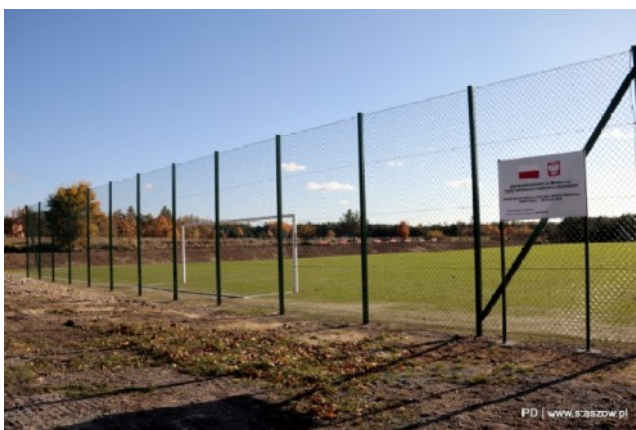
Fot. 26. Przebudowa boiska w Wiązownicy - Kolonii
