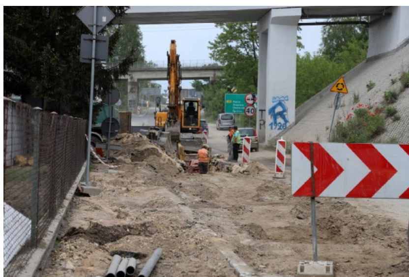
Fot. 32. Rozpoczęły się prace na ul. Towarowej w Staszowie
