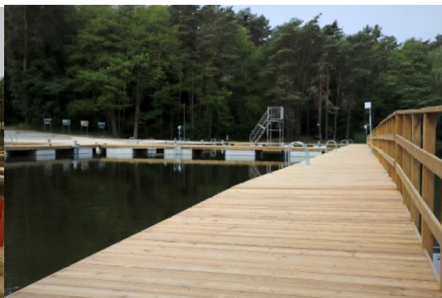
Fot 16. Golejów po pierwszym etapie rewitalizacji
