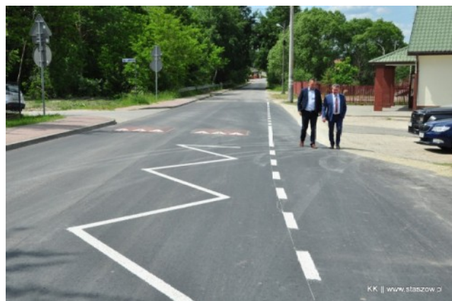
Fot 23. Przebudowa drogi w Wiązownicy Dużej
