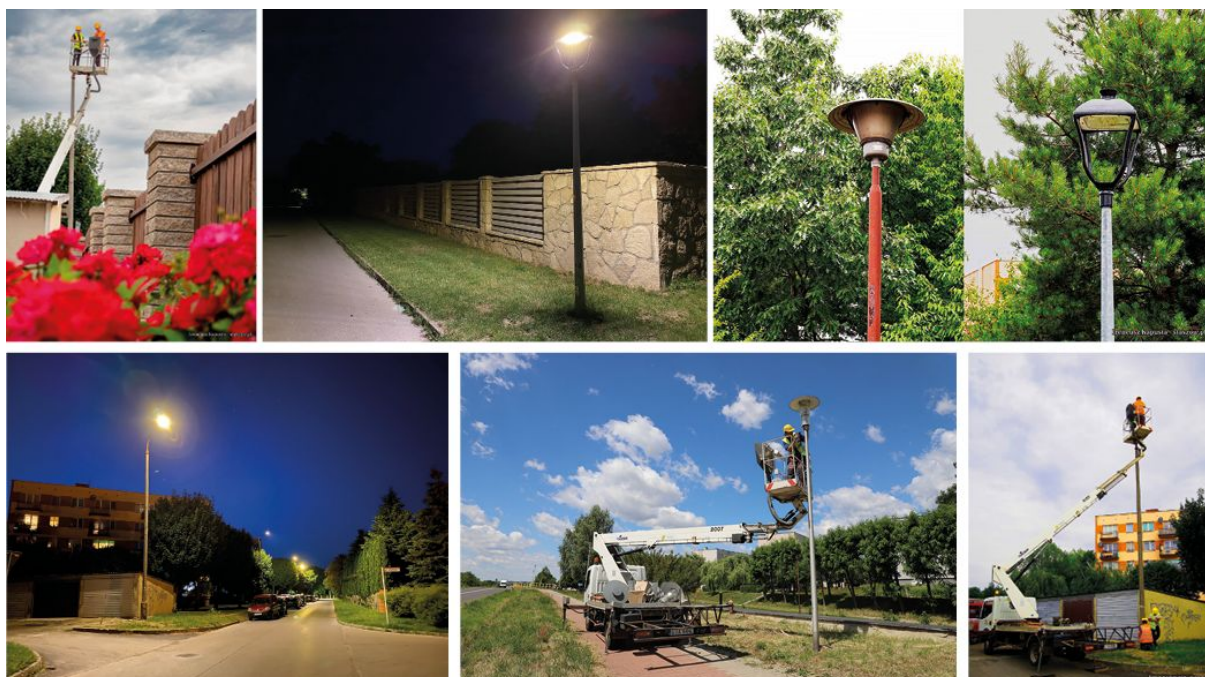
Fot. 9. Montaż nowych lamp led w Staszowie
