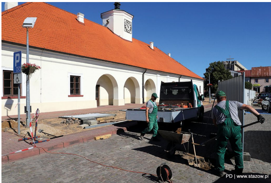
Fot. 14. Prace przy rewitalizacji ratusza w Staszowie
