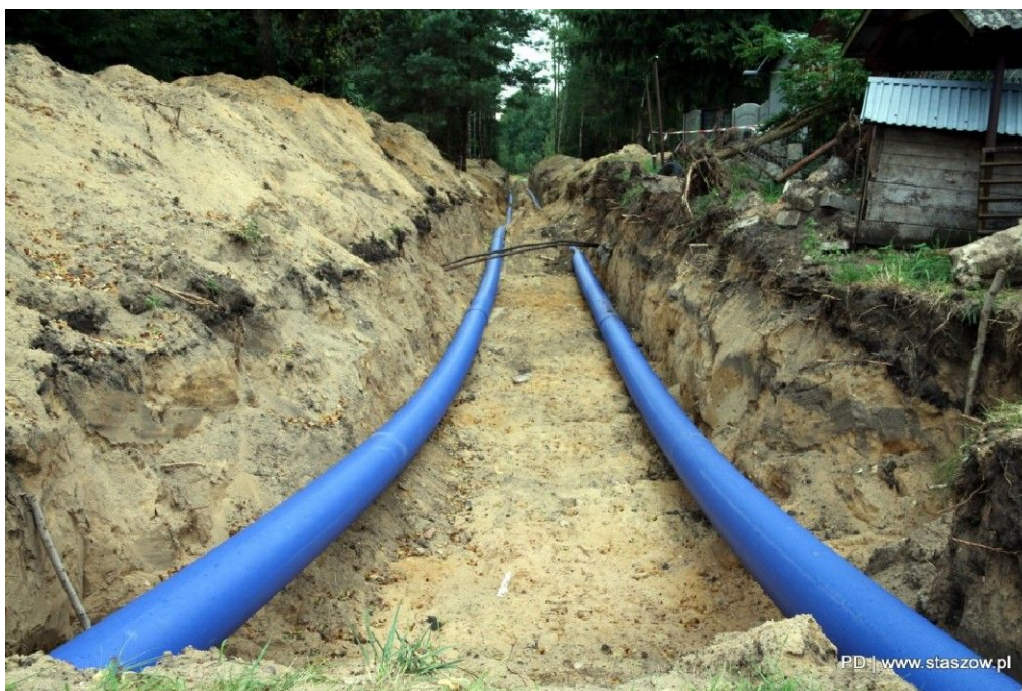
Fot. 6. Wymiana sieci wodociągowej w Staszowie
