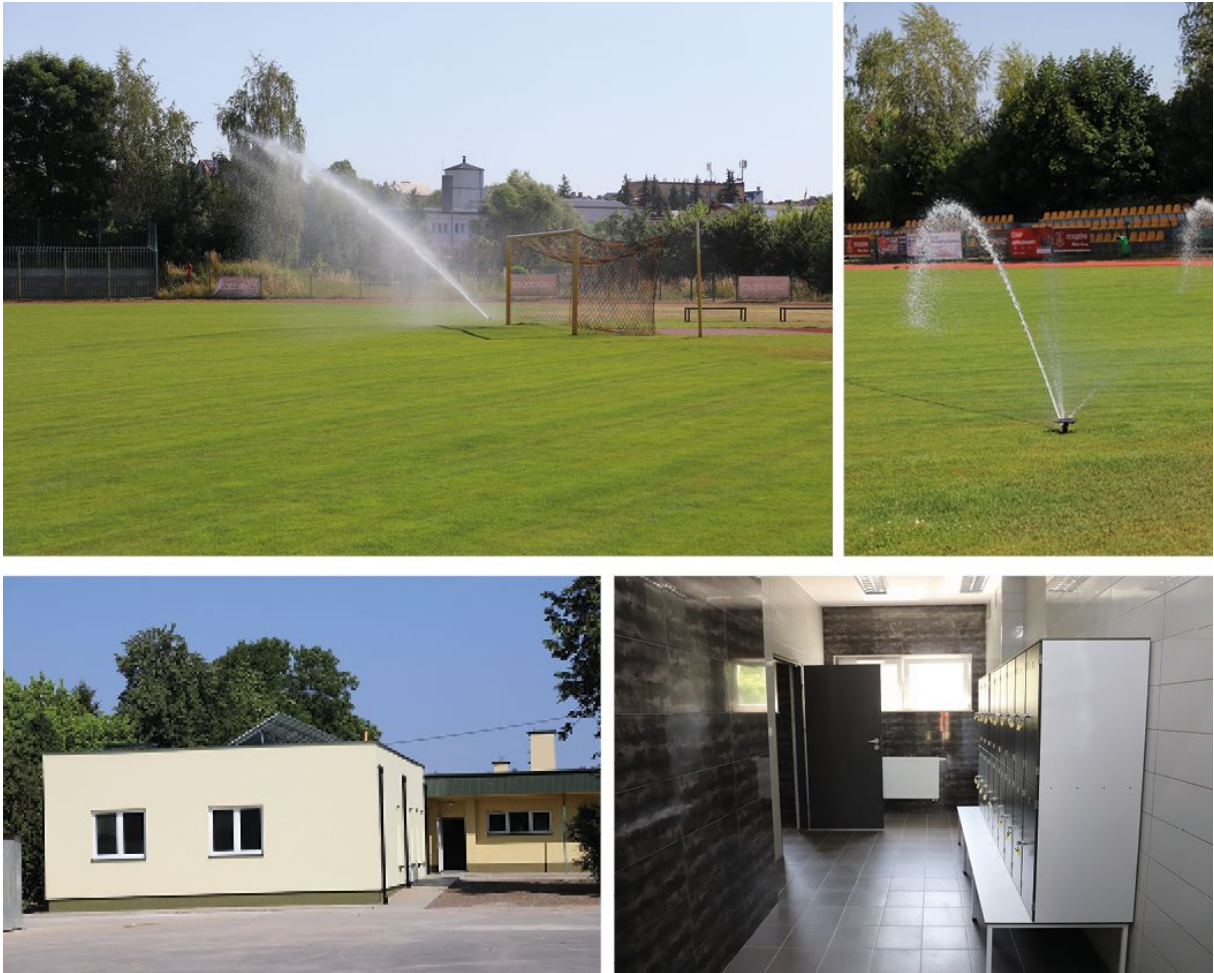
Fot. 12. Przebudowa boiska do piłki nożnej i zaplecza sportowego w Staszowie
