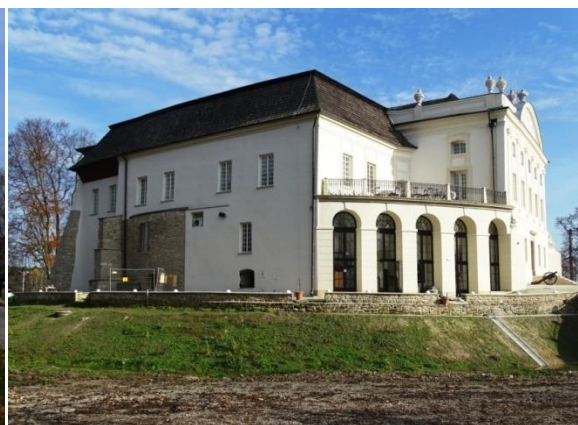
Widok na elewację zachodnią
