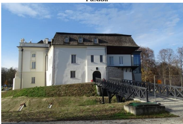
Widok na elewację wschodnią
