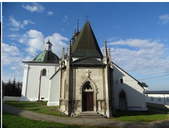
Widok na elewację wschodnią
