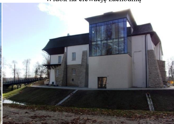
Widok na elewację tylną
