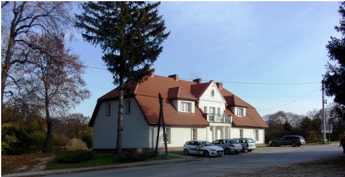
Budynek administracji, ob. Rzadzówka
