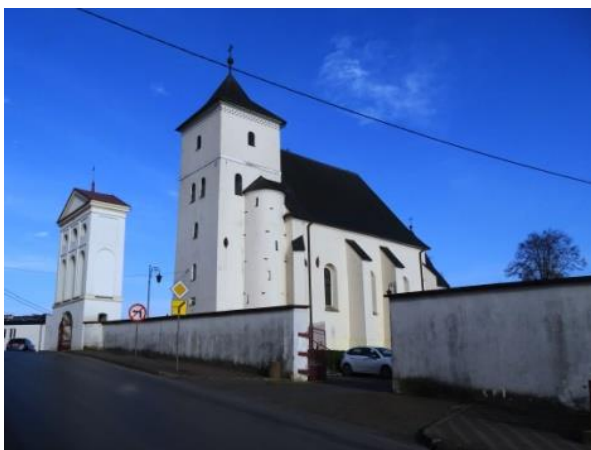
Widok na kościół od strony ul. Szpitalnej
