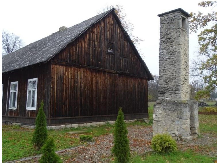
Latarnia leśna w Wiązownicy-Kolonii
