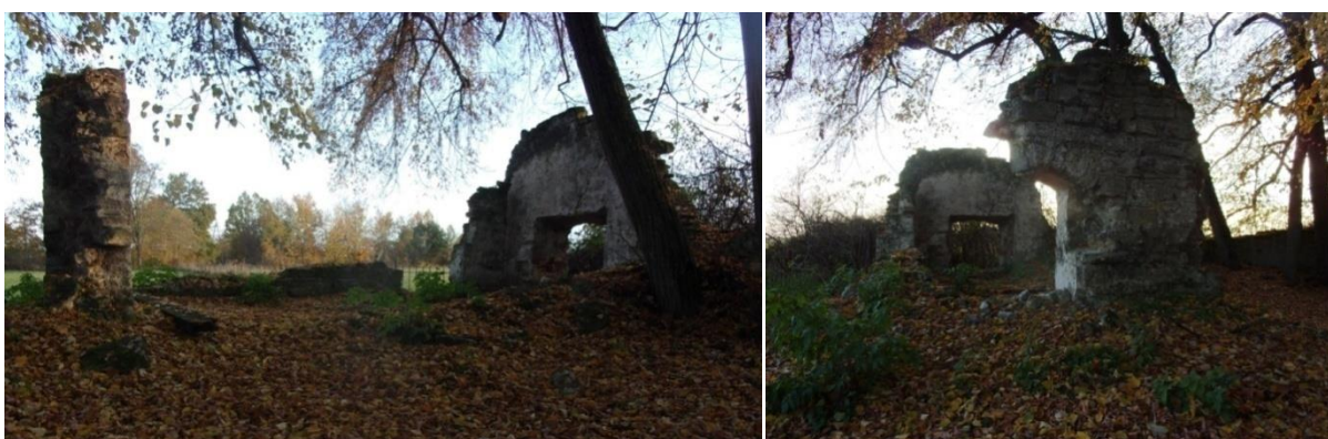
Pozostałości pawilonu parkowego (ogrodowego)
