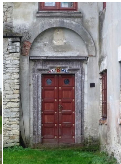
Wejście w łączniku
