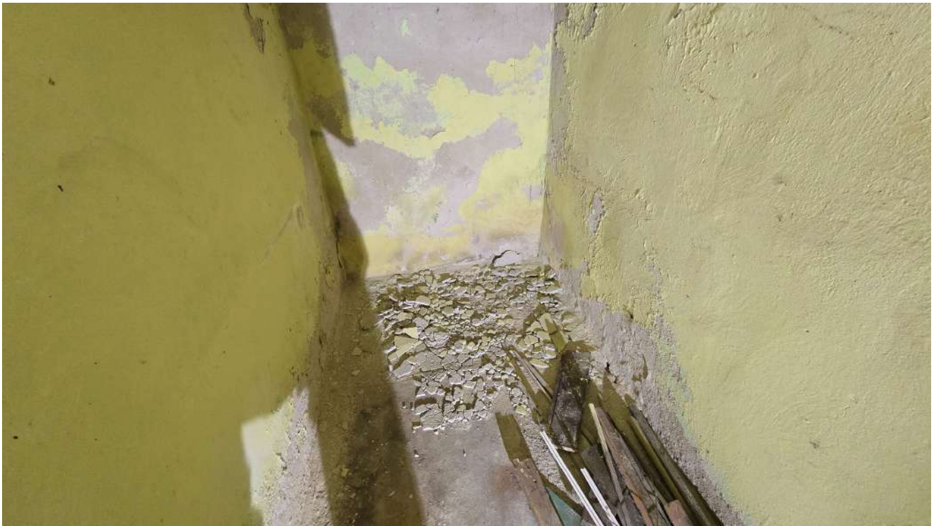
Odparzone tynki w piwnicy w części PKS
