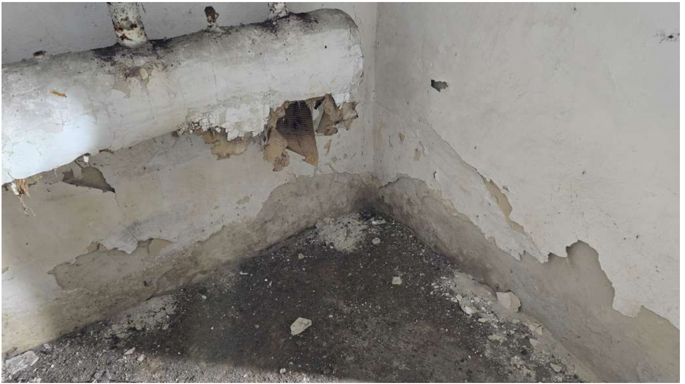
Odparzone tynki w piwnicy w części PKP
