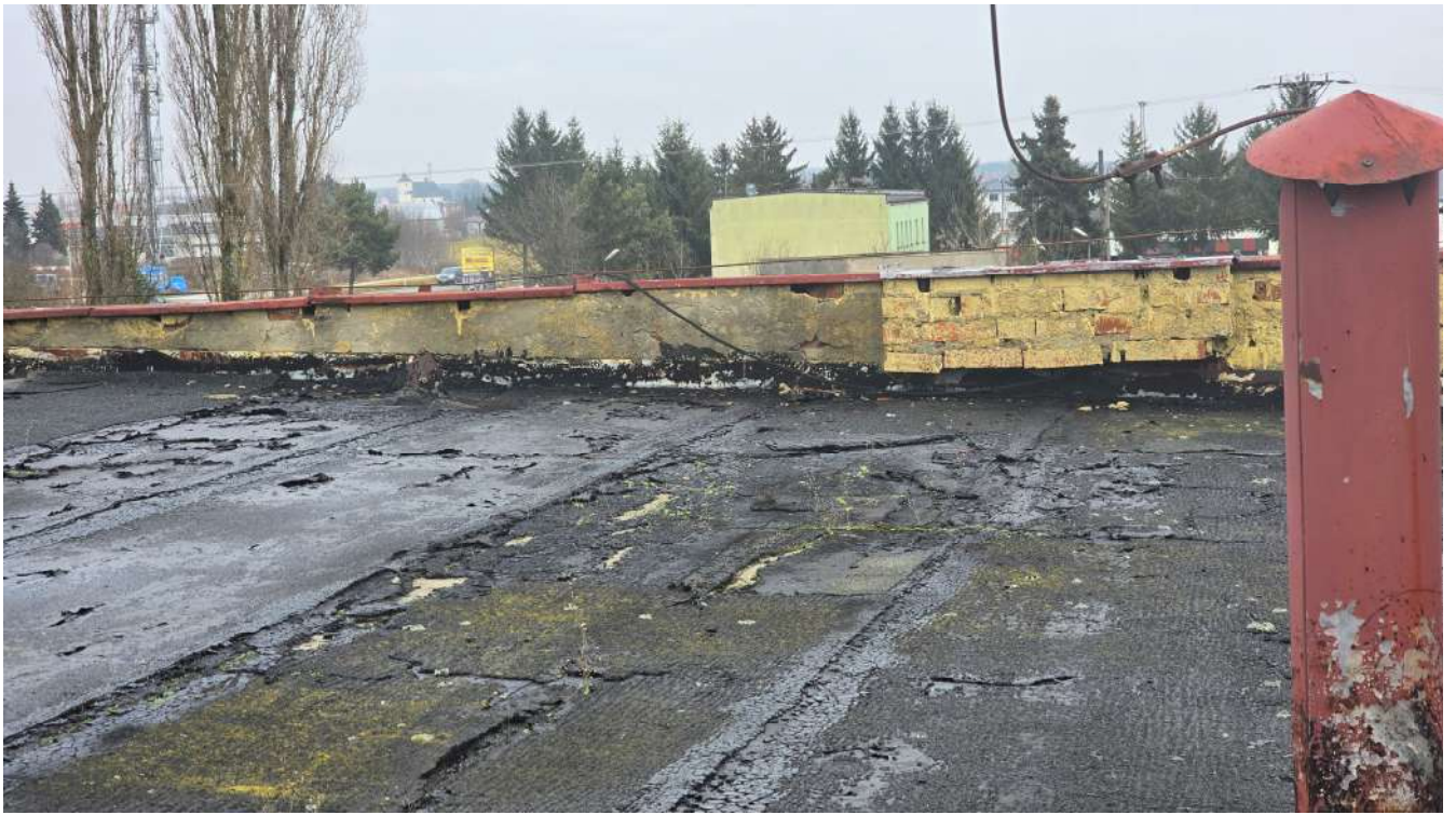
Widok zdegradowanego pokrycia z papy asfaltowej
